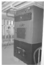
Automatische Holzfeuerung mit annähernd vollständiger Verbrennung und ohne Filter
